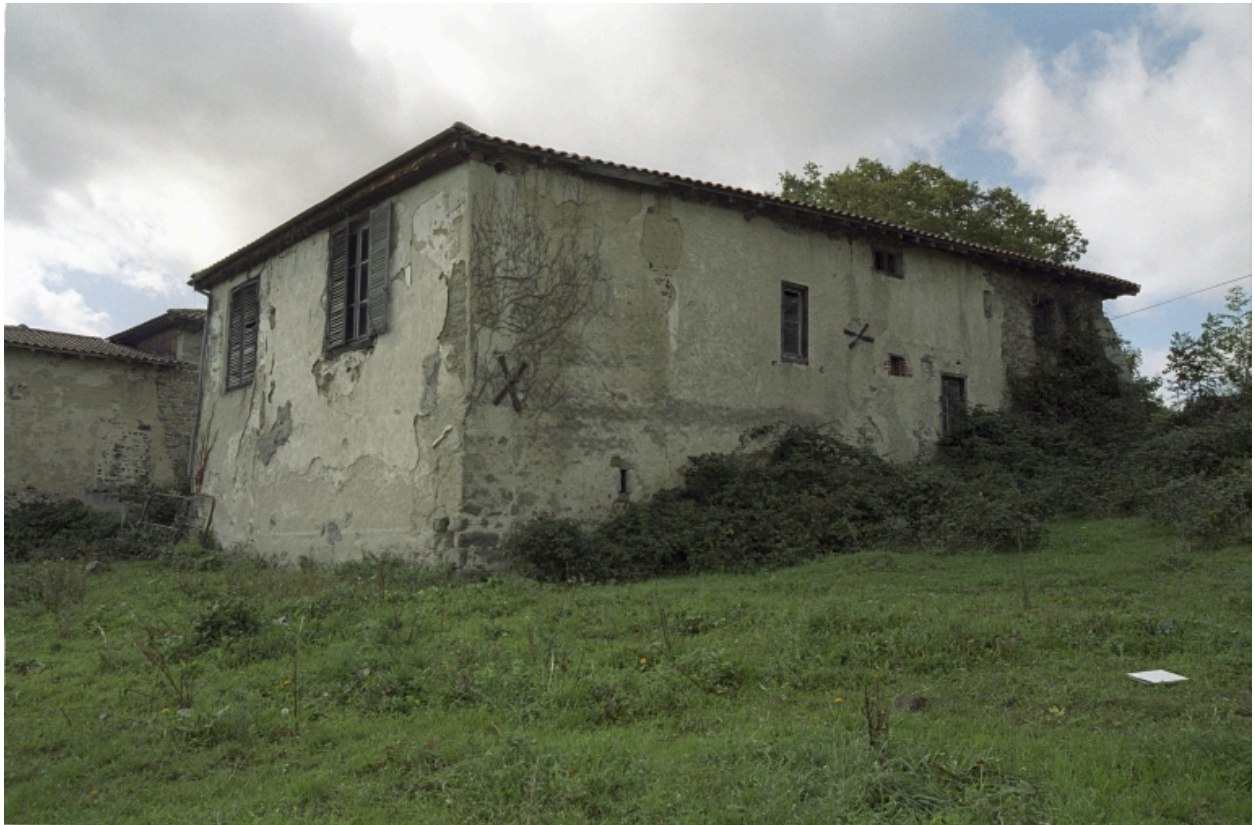
Vue d'ensemble du bâtiment nord (élévation postérieure) depuis le nord-est.
