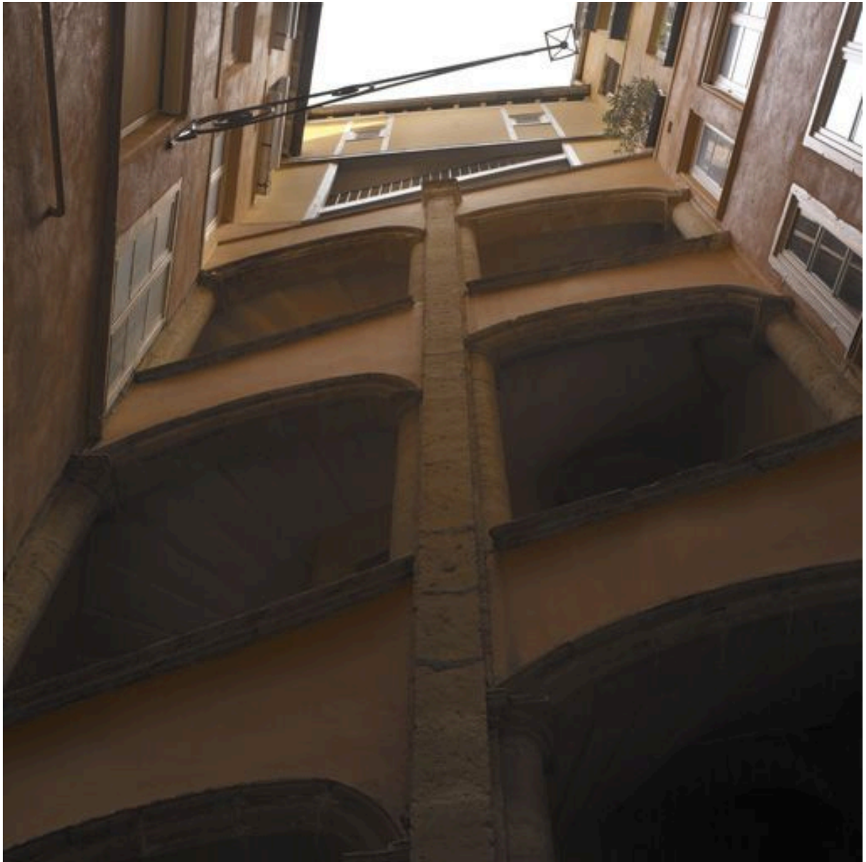
Cour I, vue générale par-dessous de l'escalier
