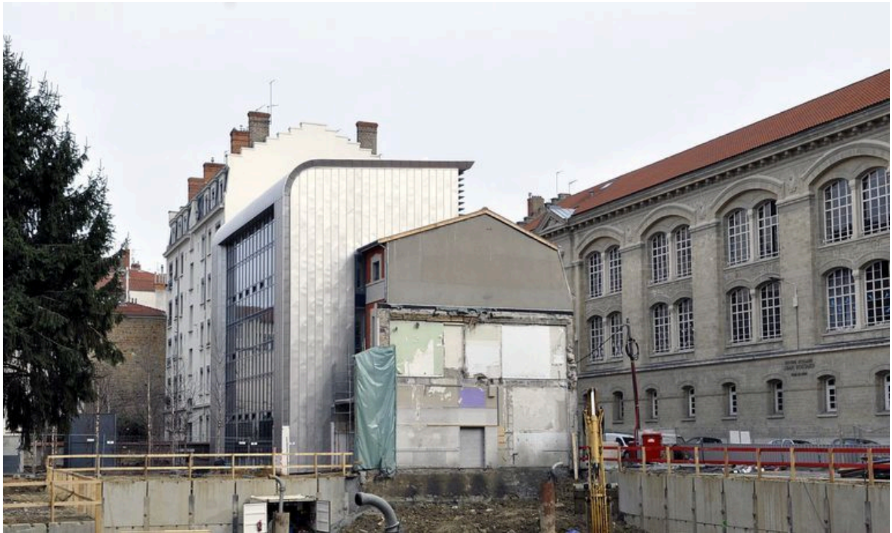
Vue lors des travaux : extension à l'arrière
