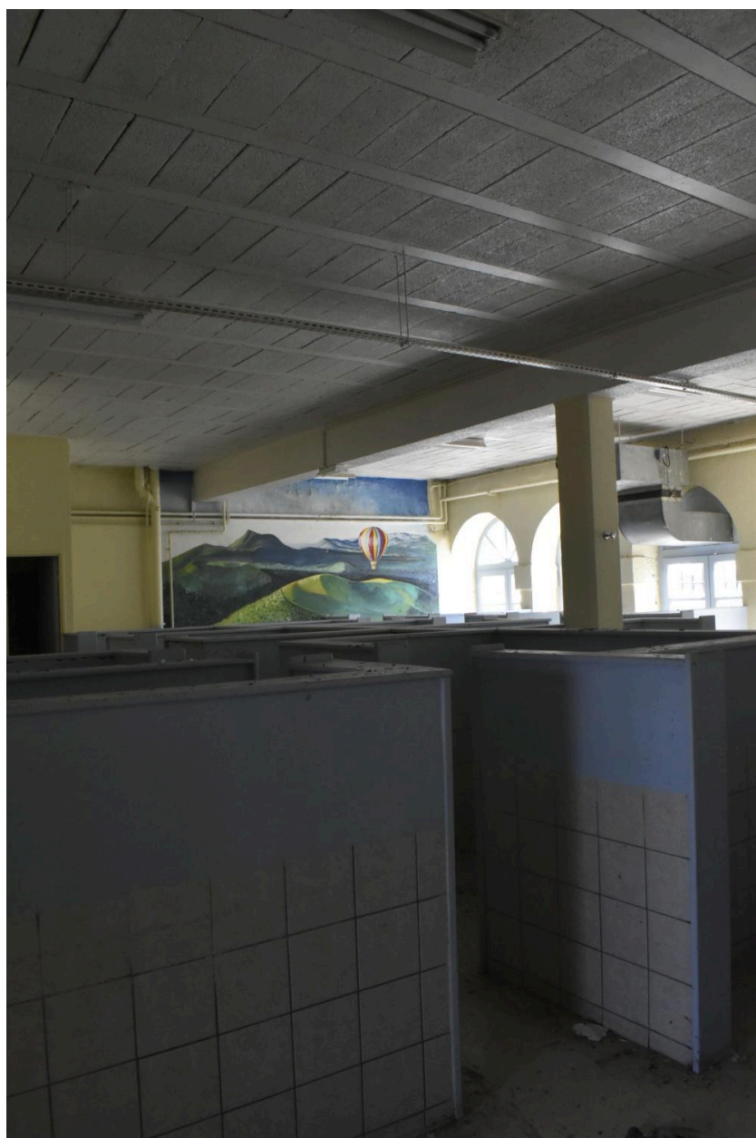
Salle des parloirs dans le bâtiment E.
