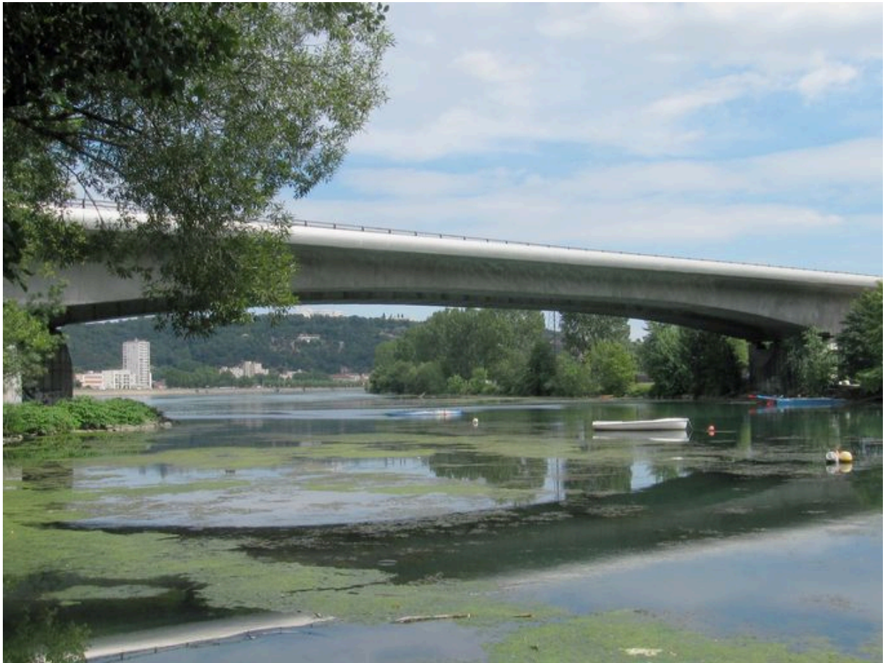
Travée centrale, face amont (depuis la rive droite)
