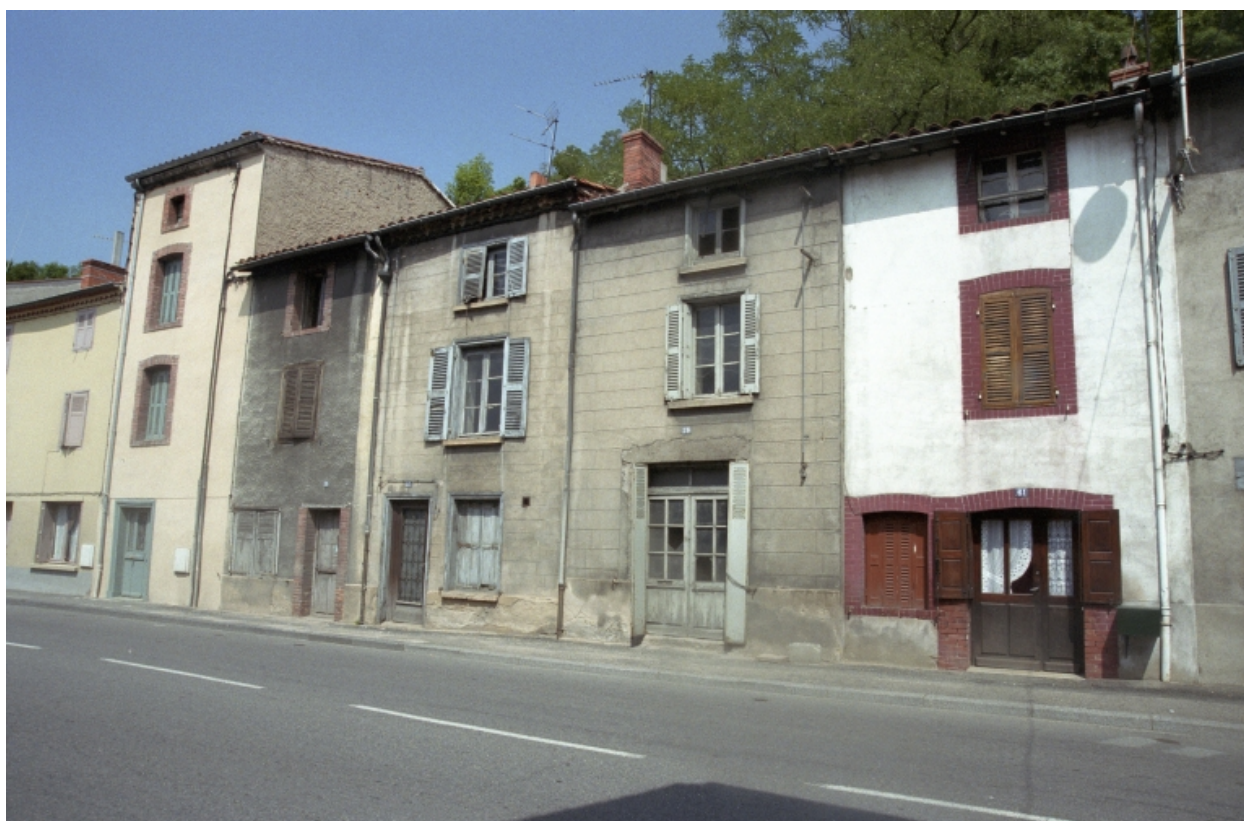
Boën, îlot 17, Lyon (rue de) 61. Vue générale de la façade sur rue.
