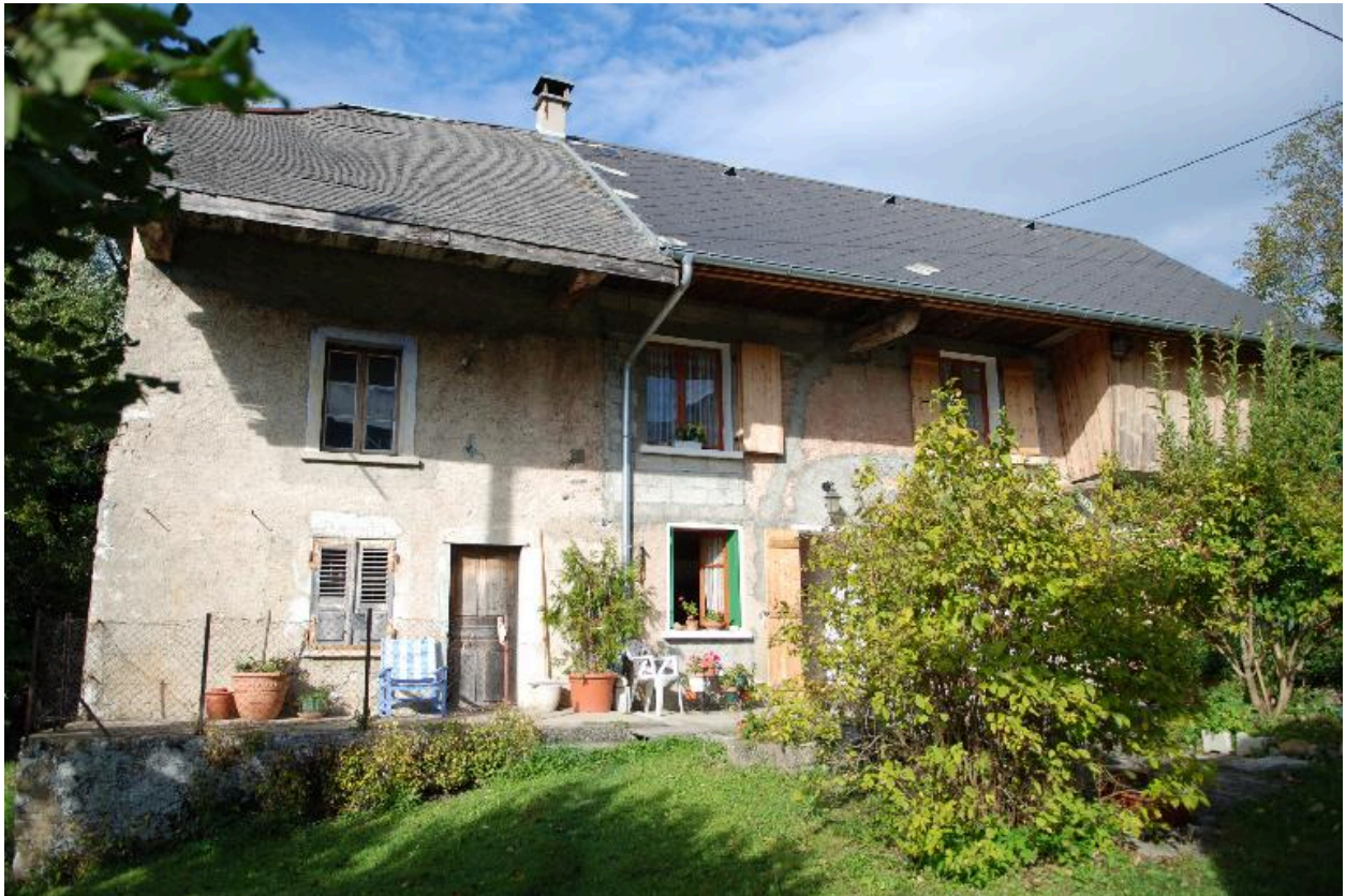
Dray (la), ferme, 2014 B2 235, 1153 à 1155. Vue d'ensemble de la façade principale.
