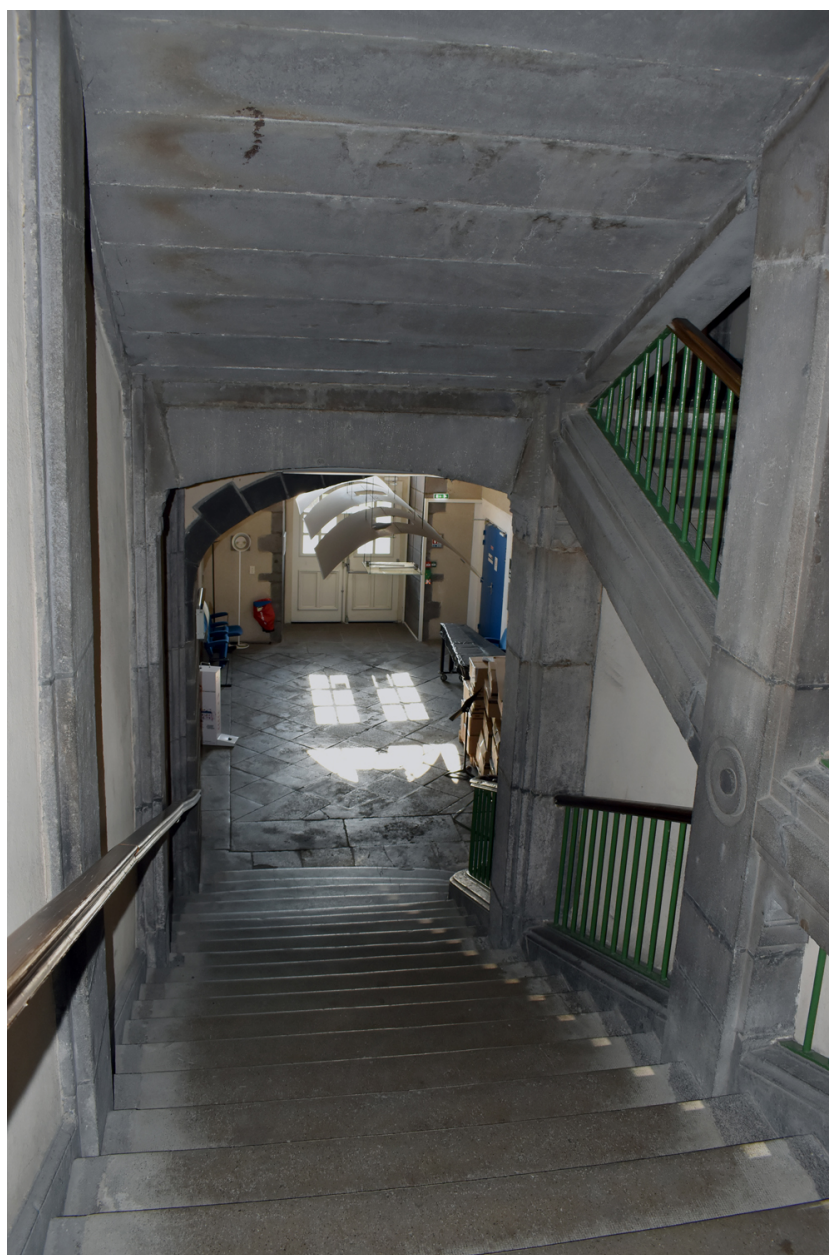
Escalier D : première volée entre l'étage de soubassement et le rez-de-chaussée, depuis le haut
