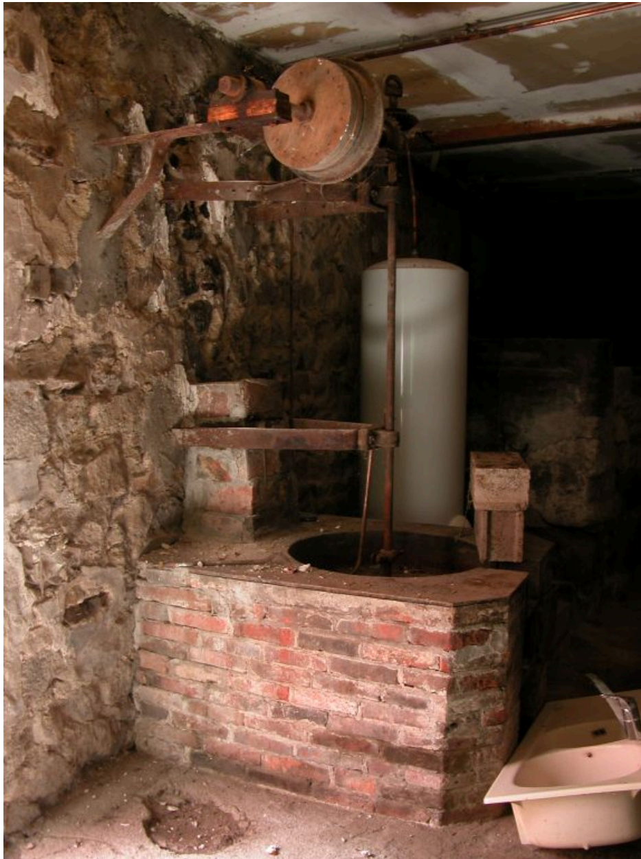
Vue d'ensemble de la cuve à chauffe.
