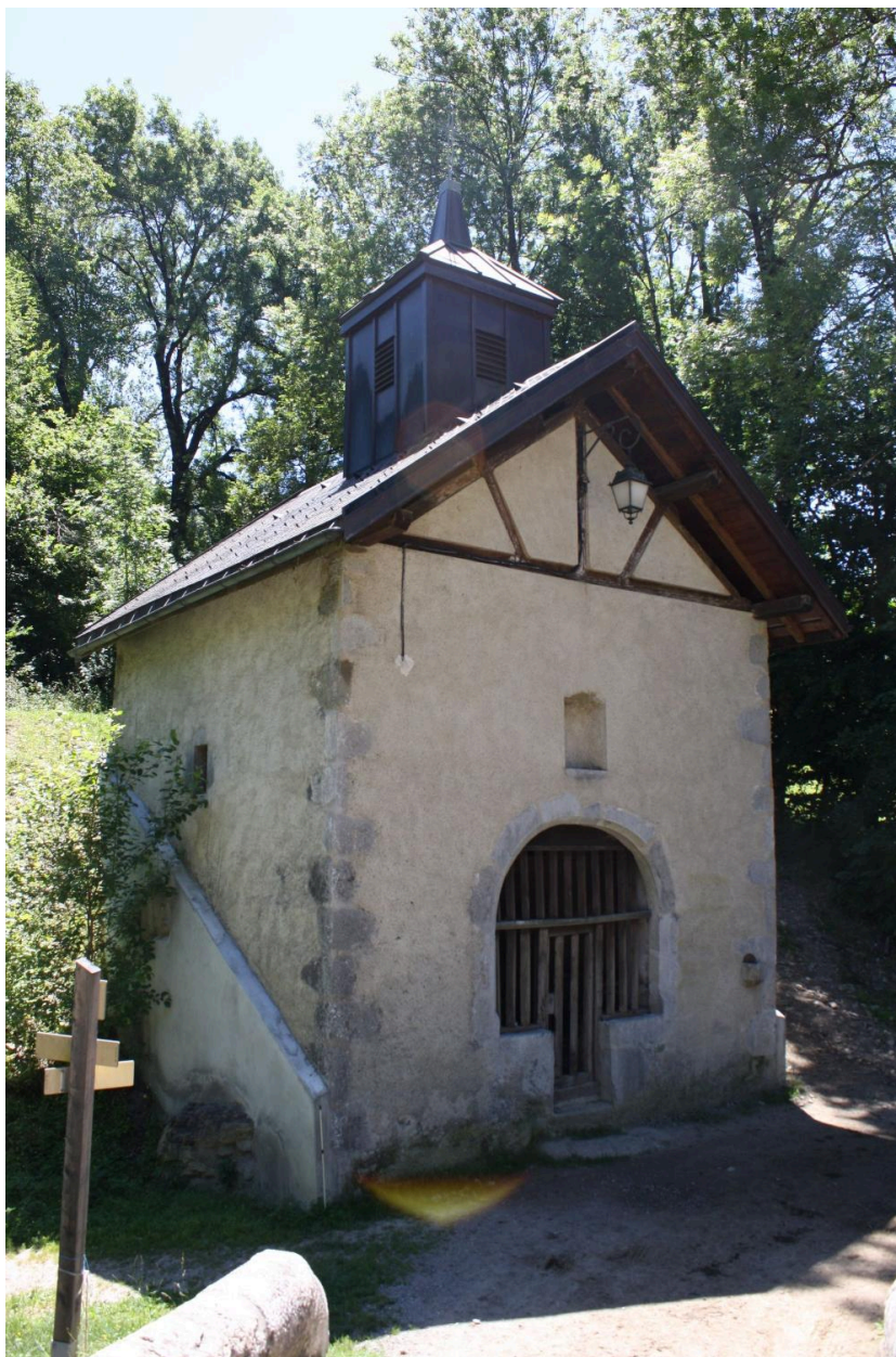
Pont de la Vacherie, détail contexte, chapelle de la Bossenaz
