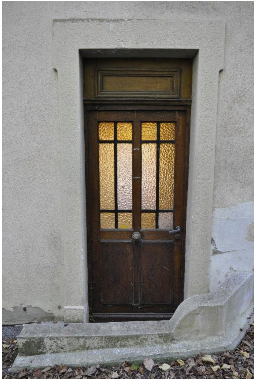
Bâtiment central, élévation ouest : vue de la porte centrale
