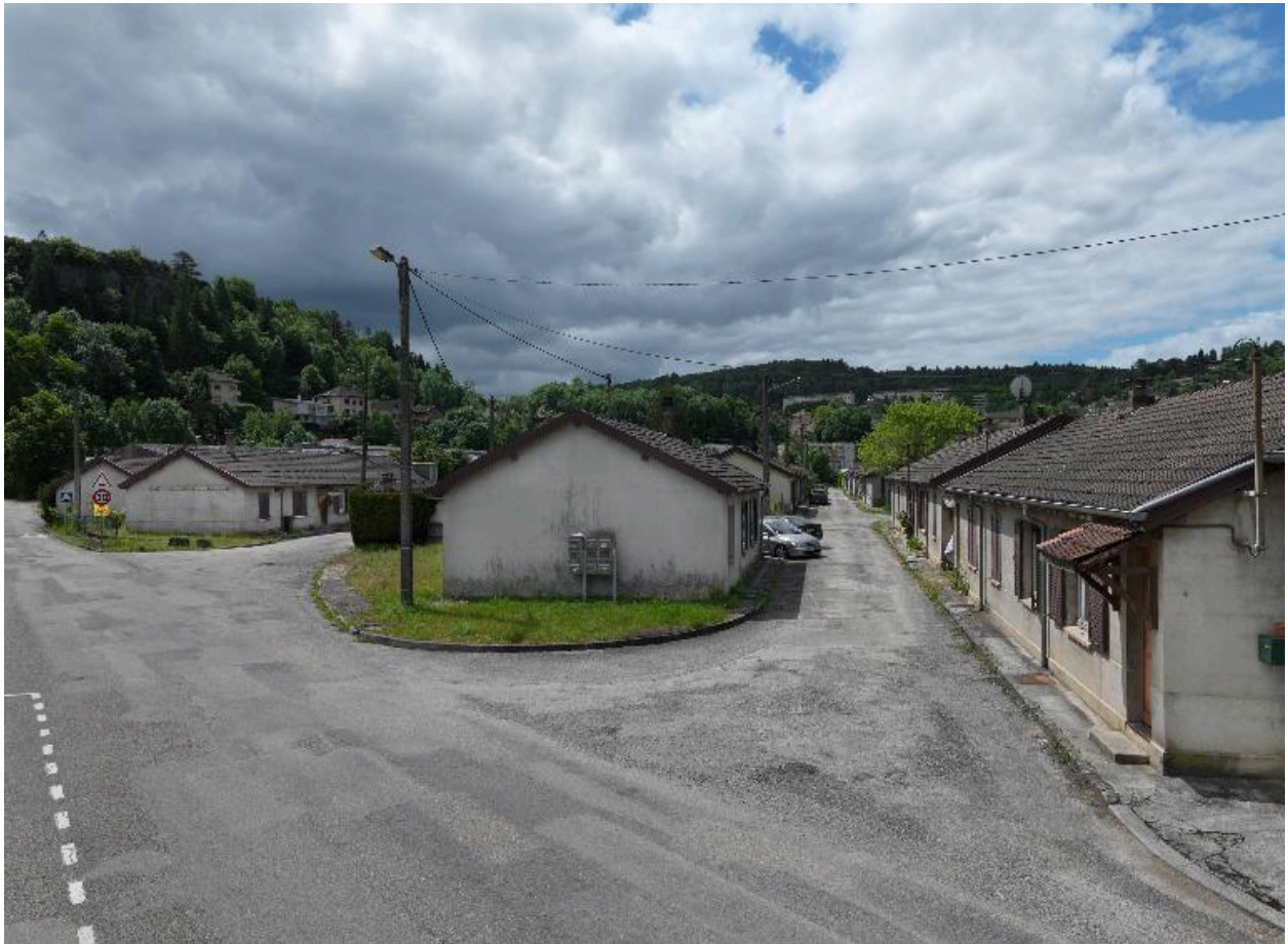
Vue de la cité Dortan : réseau viaire
