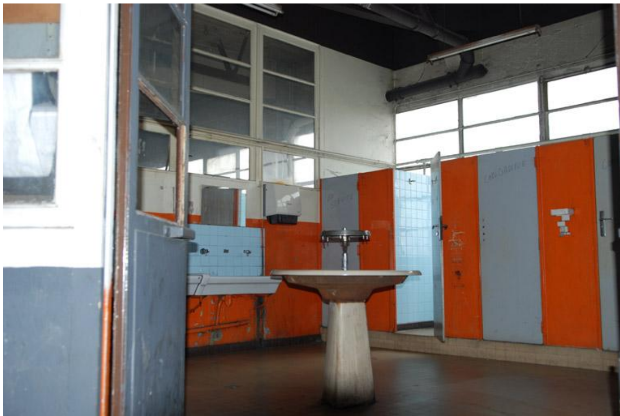
Lavabos et toilettes des salariés du garage
