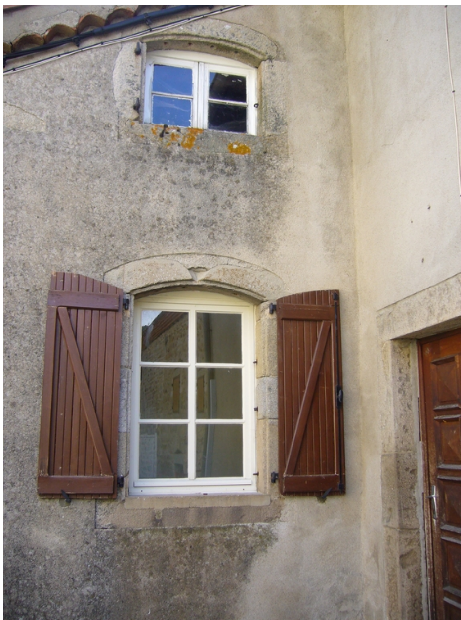
Détail des ouvertures arrières : fenêtres à linteau en arc segmentaire.
