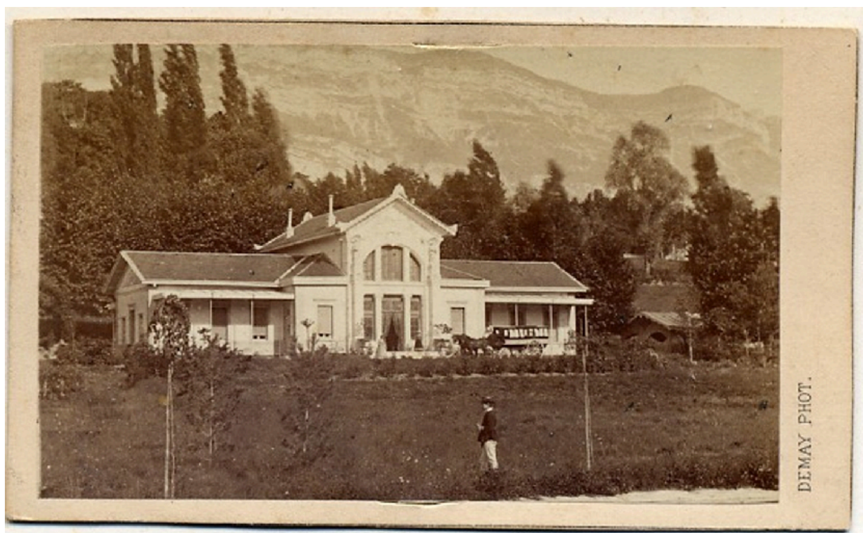
Vue de l'ancien établissement prise de l'ouest
