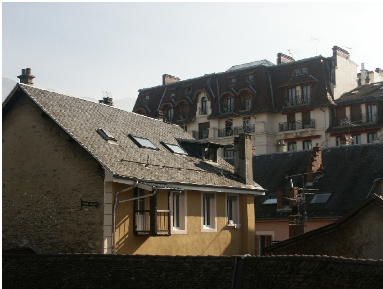
Elévation sur la cour de l'aile orientale
