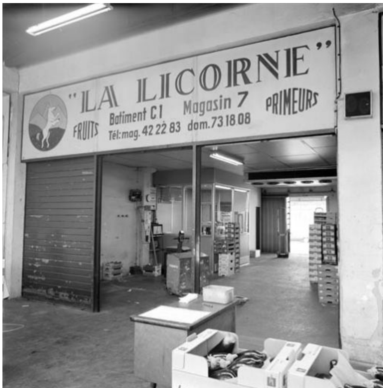
Bâtiment C1 : vue intérieure de la Licorne avec l'enseigne
