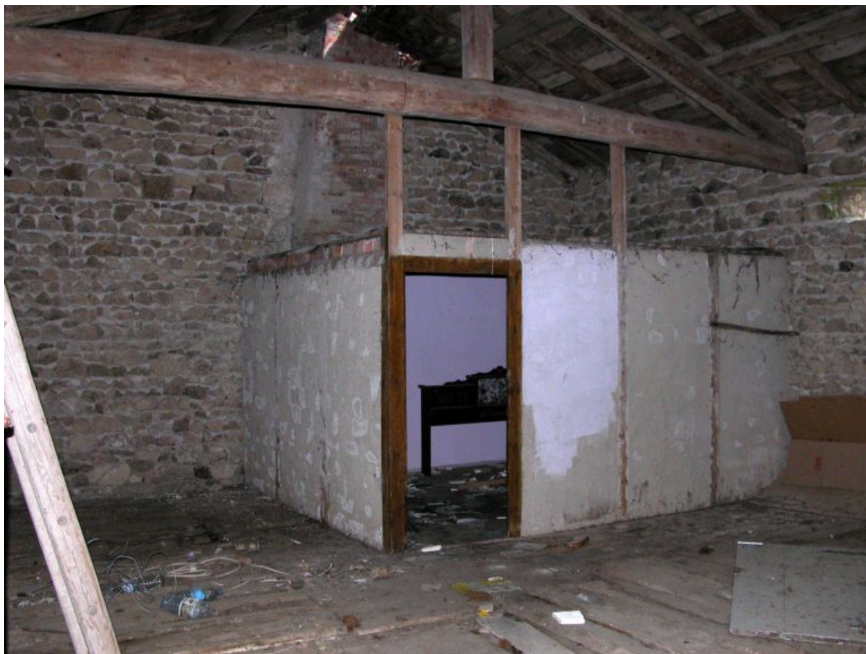
Vue intérieure de la grange vers ne lord, avec la chambre haute.
