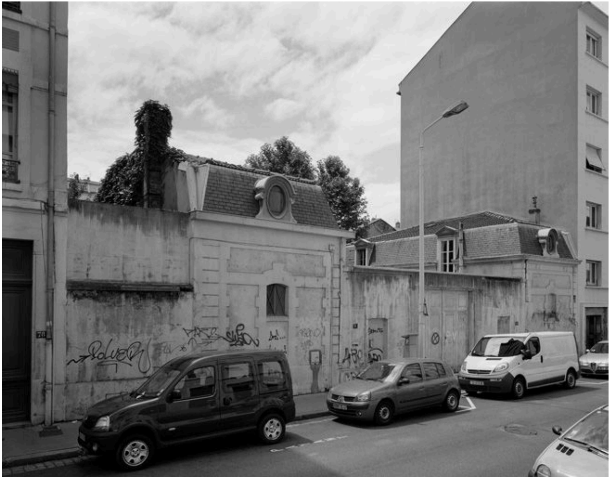
Pavillons d'entrée rue Crillon
