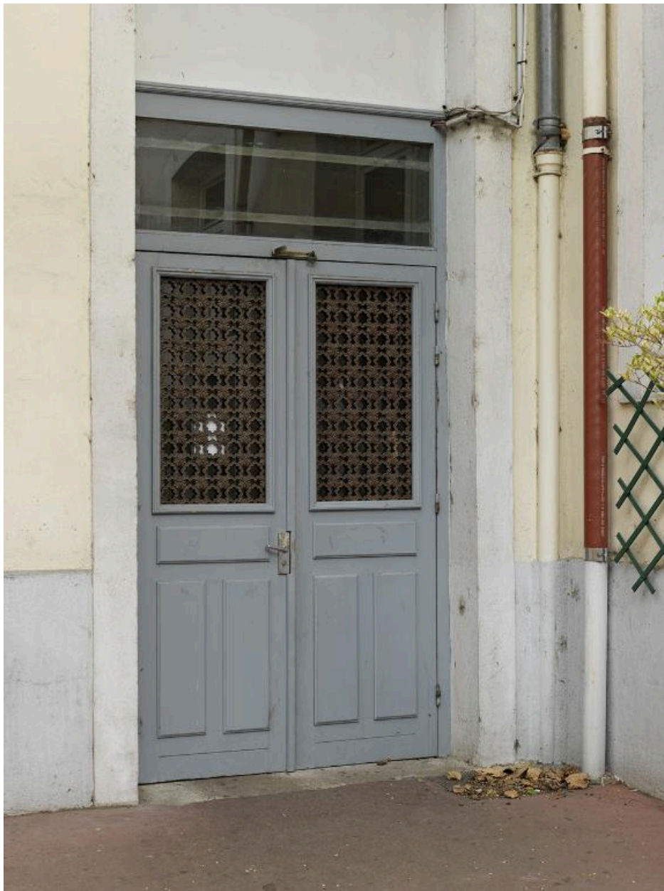
Cour d'honneur, élévation nord, porte menant à l'escalier B
