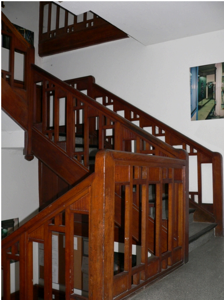
Escalier de l'entreprise
