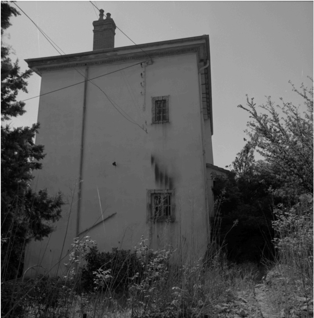
Maison de notable (type VII), dite Les Yuccas, 10 boulevard de l'Industrie (détruite après inventaire) : élévation latérale droite.
