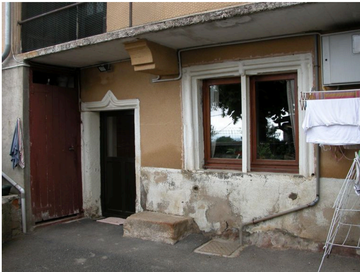
Pin (le) (1986 AC 78). Ferme, détail du rez-de-chaussée.
