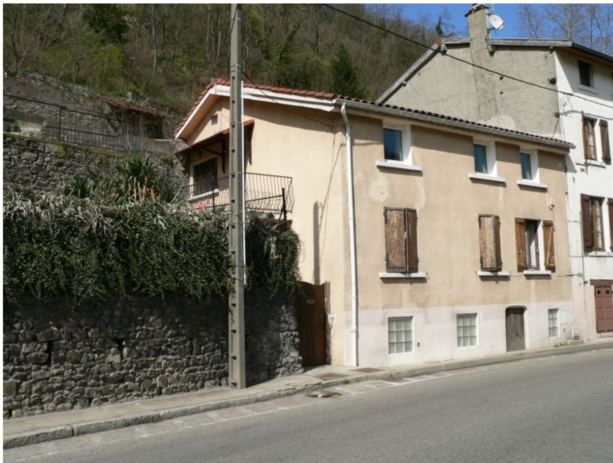
Façade sur rue et latérale gauche
