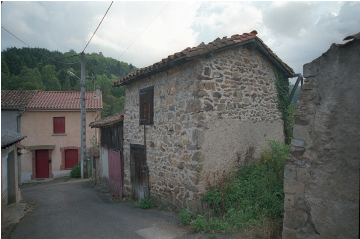
Sail-sous-Couzan, La Font Fort (1986 B1 404). Loge de type E2b2. Vue d'ensemble.
