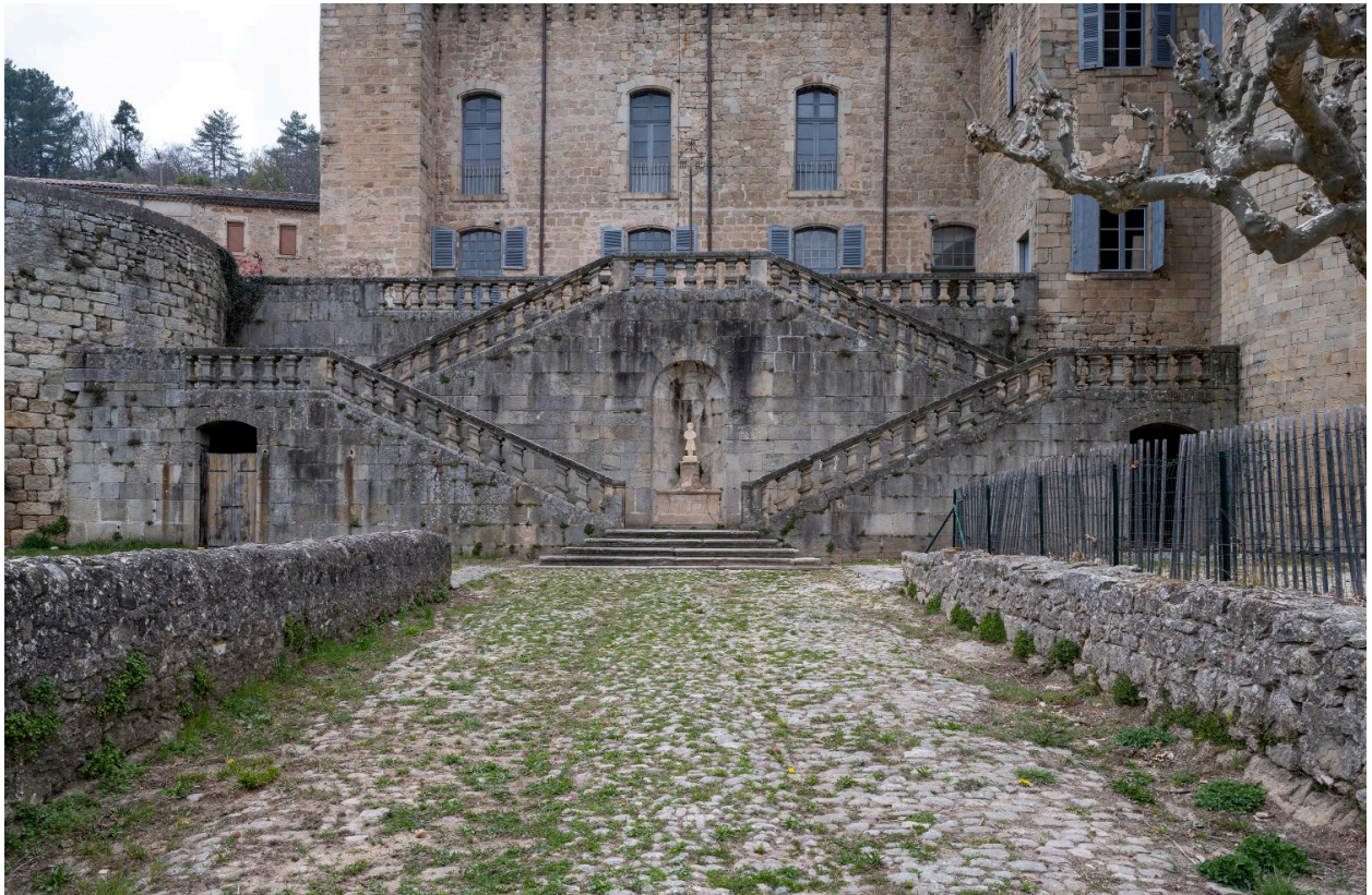
Escalier extérieur, vue d'ensemble
