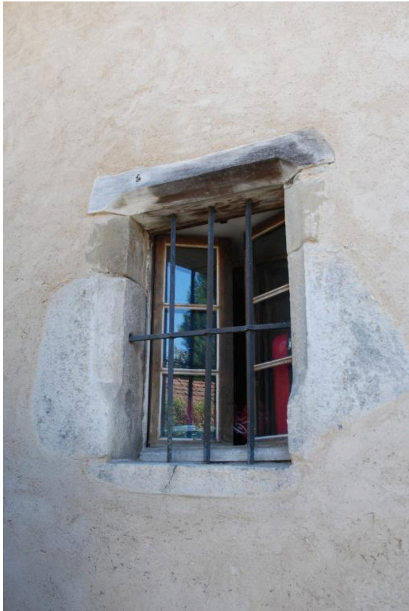
Détail d'une fenêtre à encadrement à cavet et congés en pierre et bois (façade nord).
