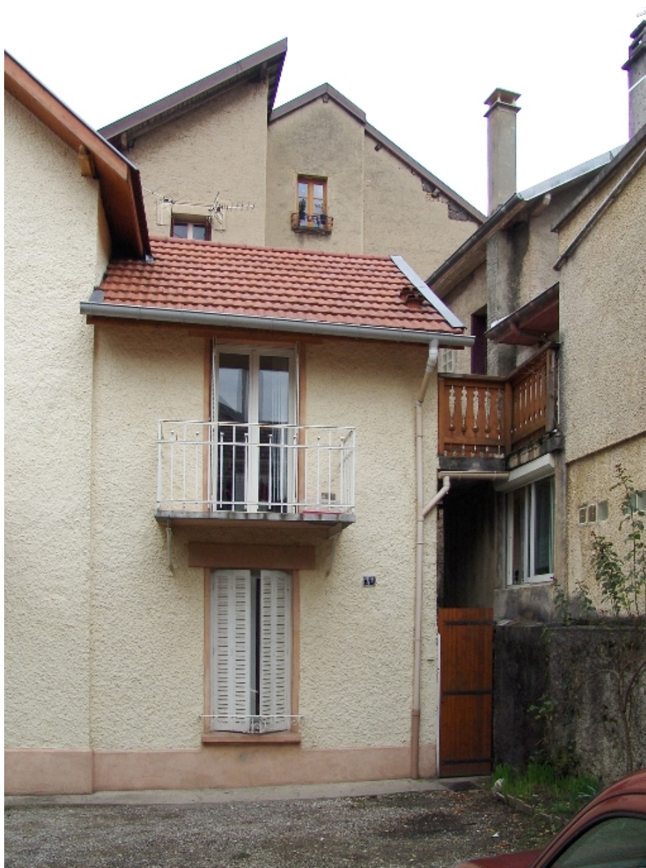
Façade de l'aile en retour
