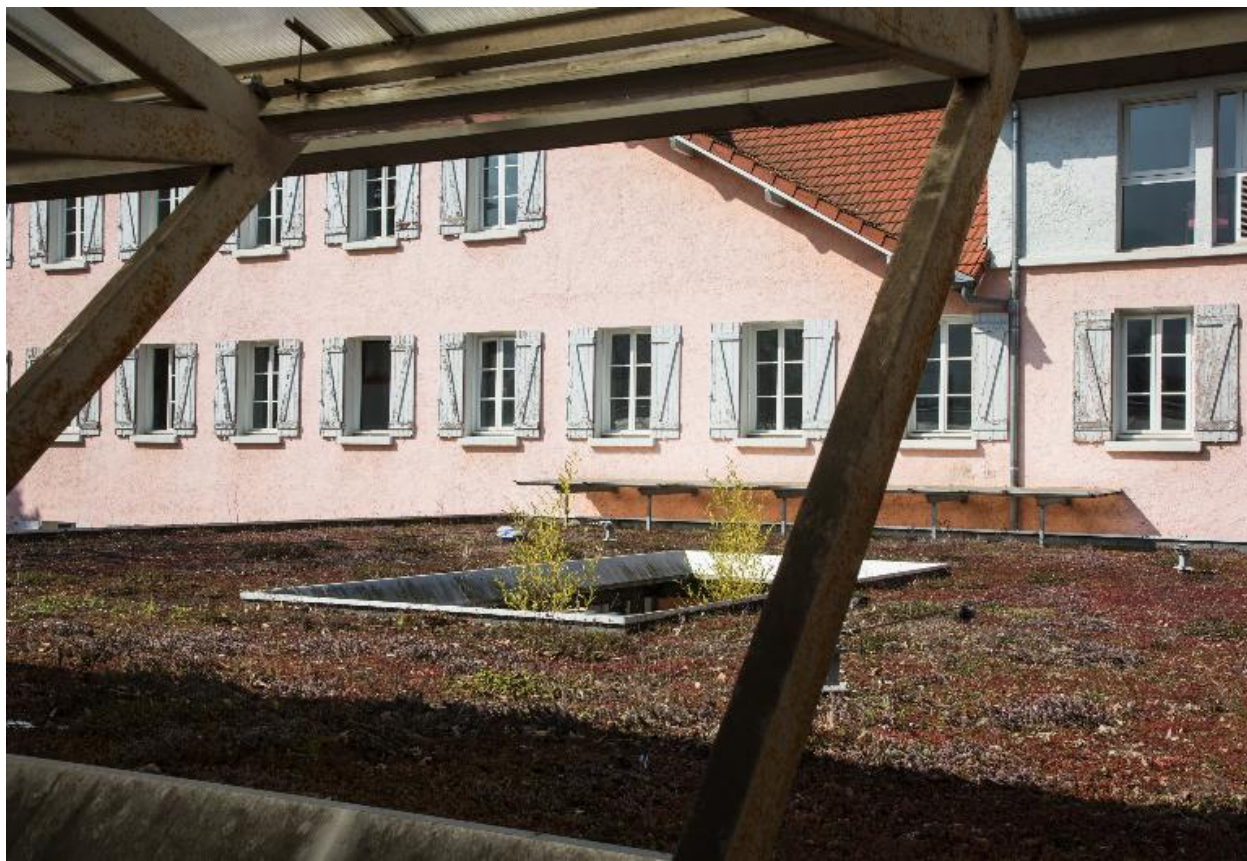
Passage C : toiture végétalisée
