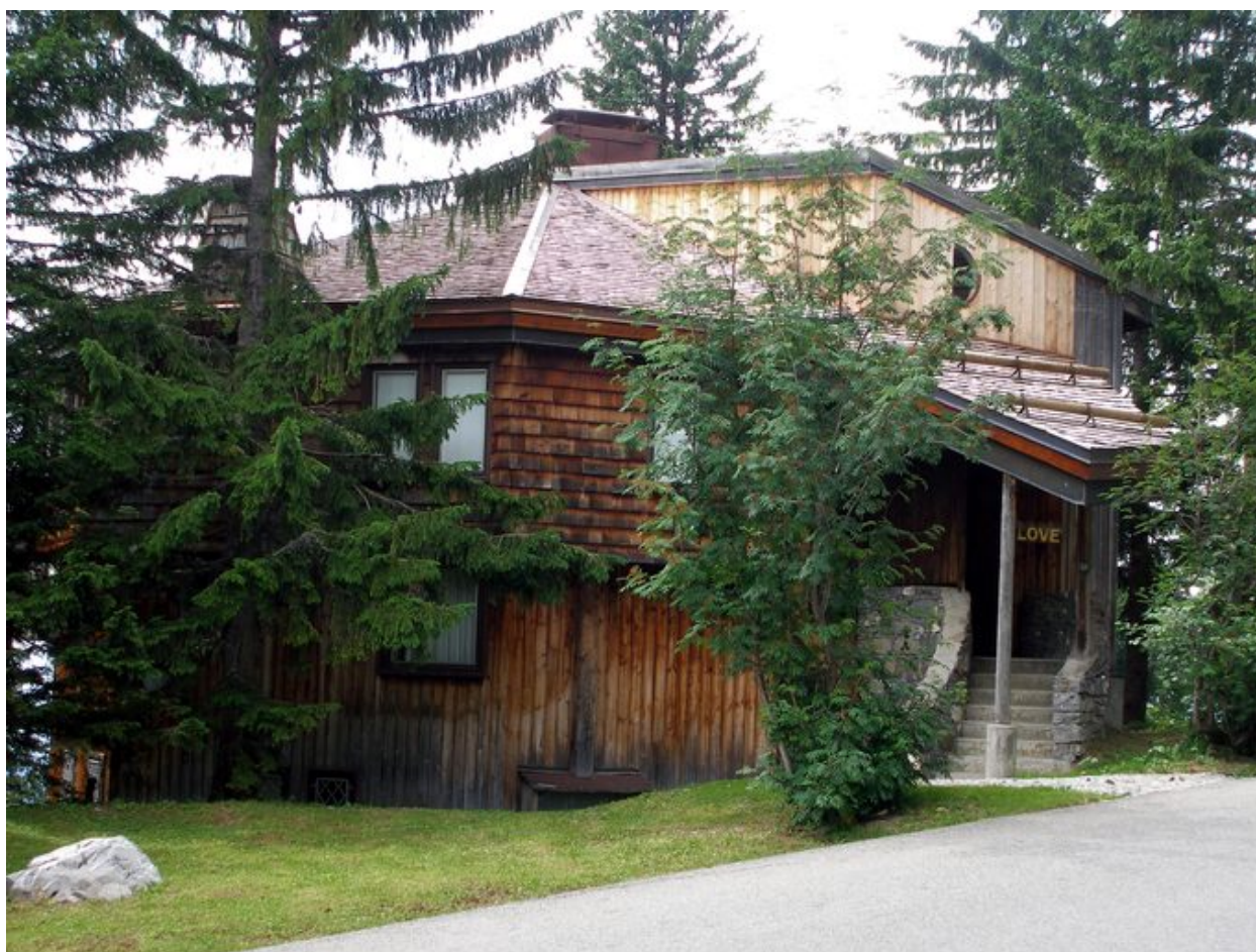
Vue d'ensemble depuis la route
