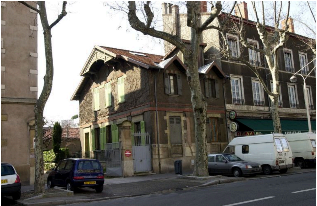
Vue de la maison de gardien depuis le cours Suchet
