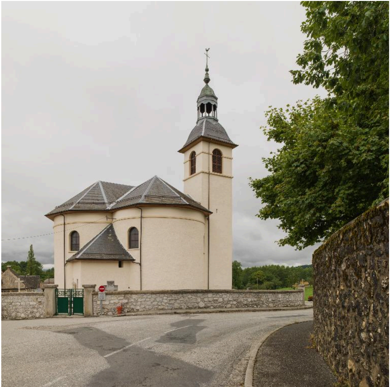
Vue d'ensemble de l'église de trois quarts sud-est.
