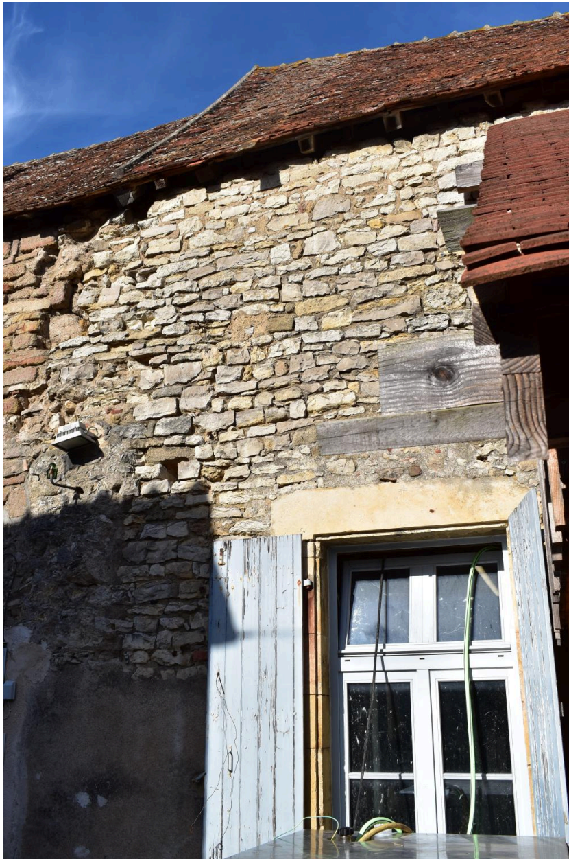
Détail du mur gouttereau méridional;
