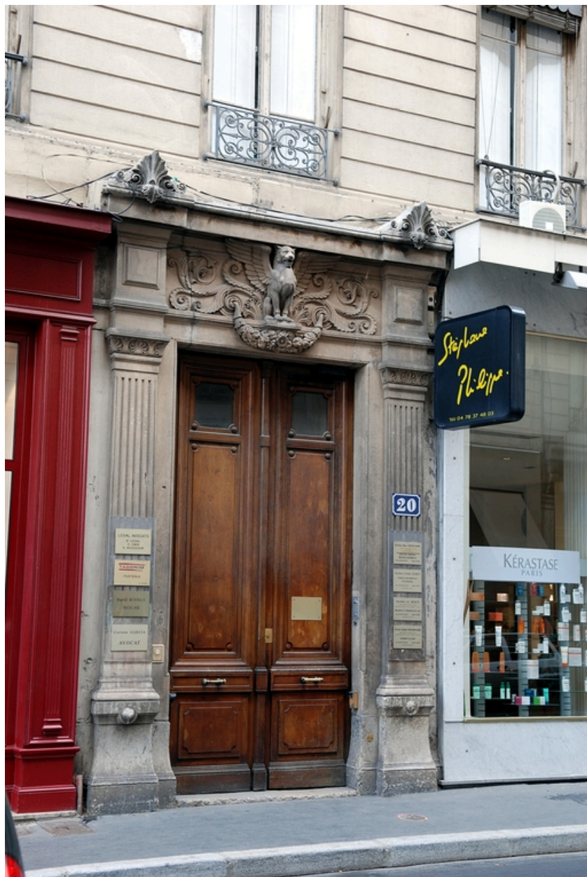
Élévation rue Gasparin : la porte
