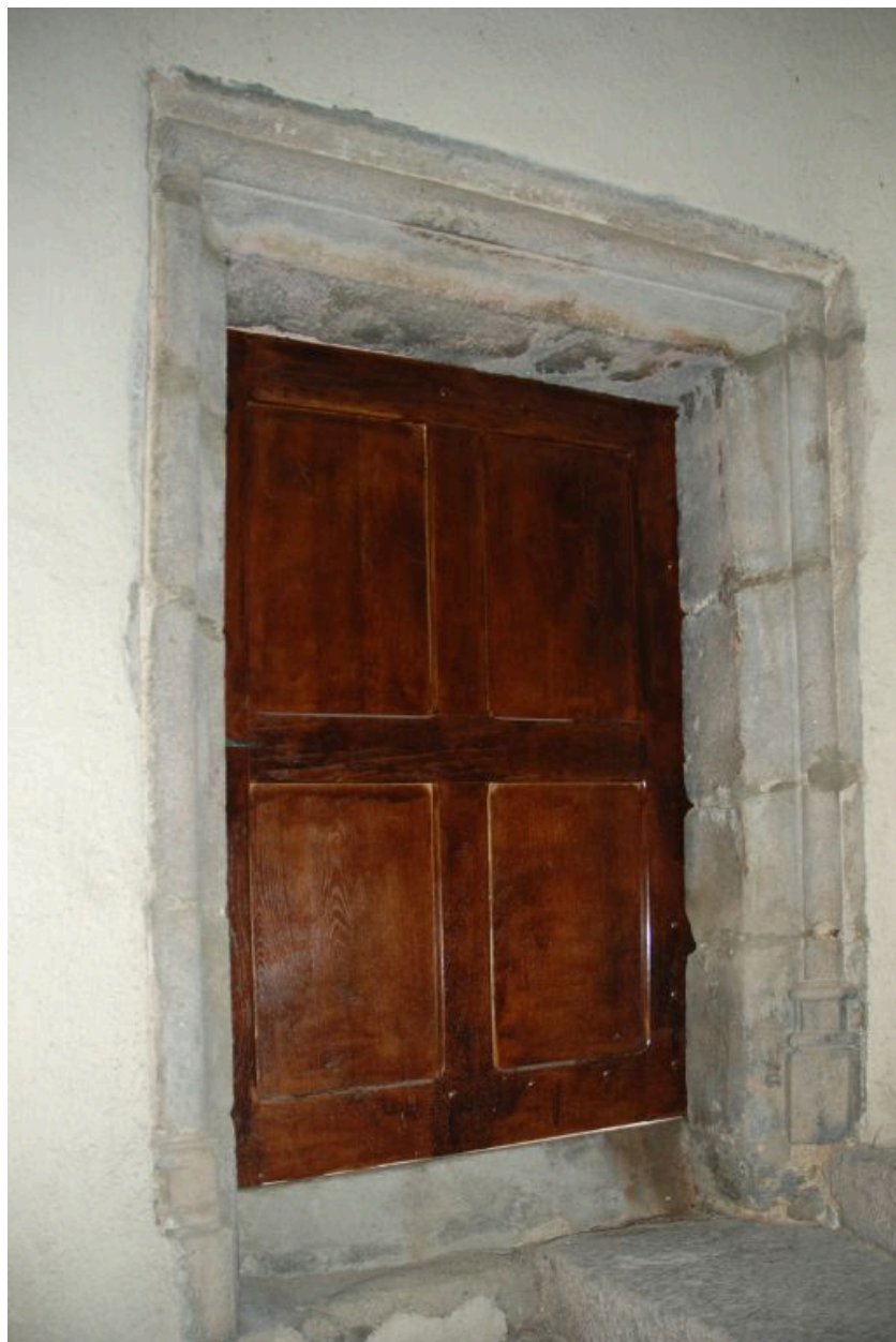
Porte palière du 2e étage.
