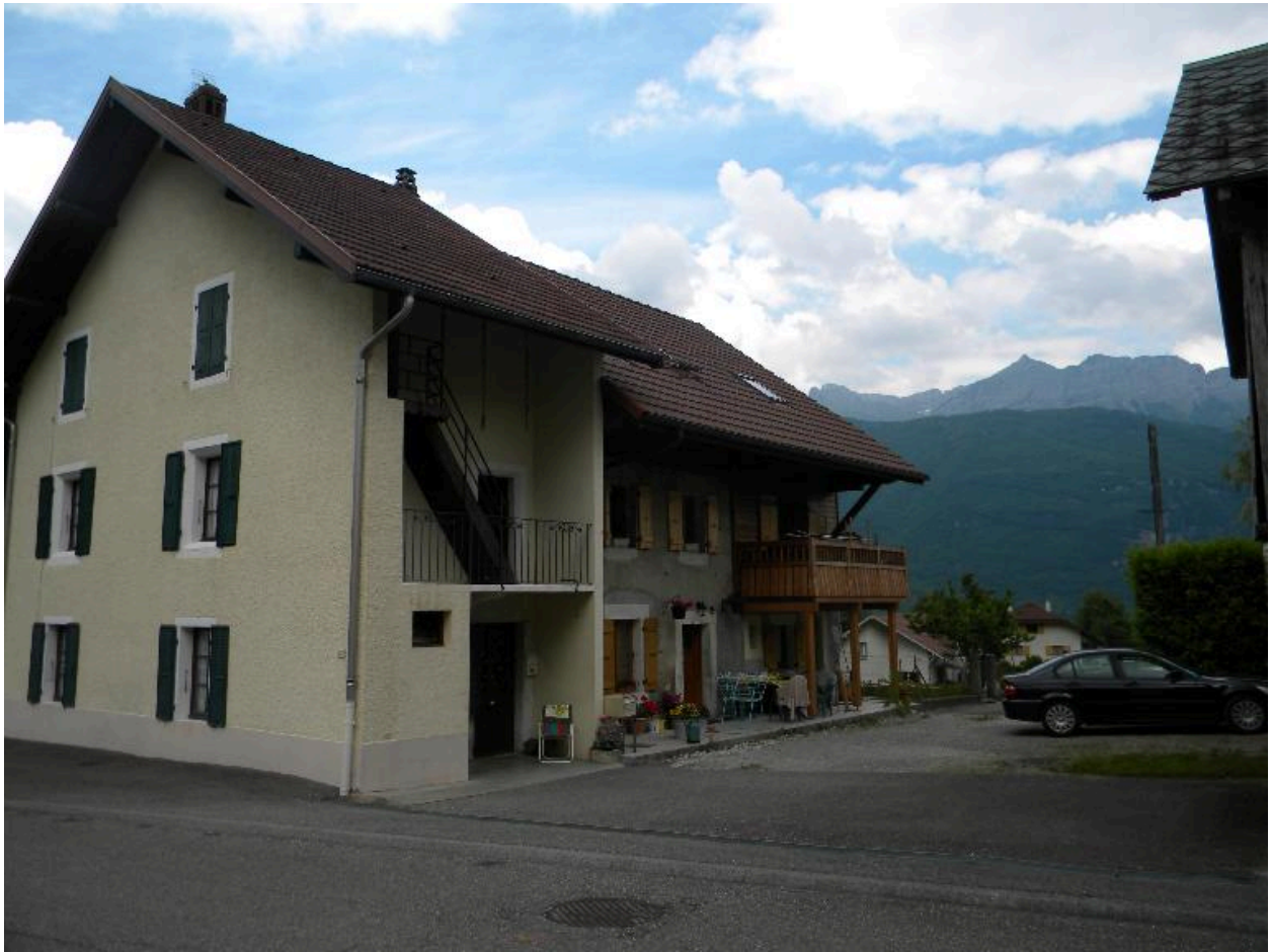
Vue de l'alignement de bâtiments mitoyens (2008 B3 555, 1487).
