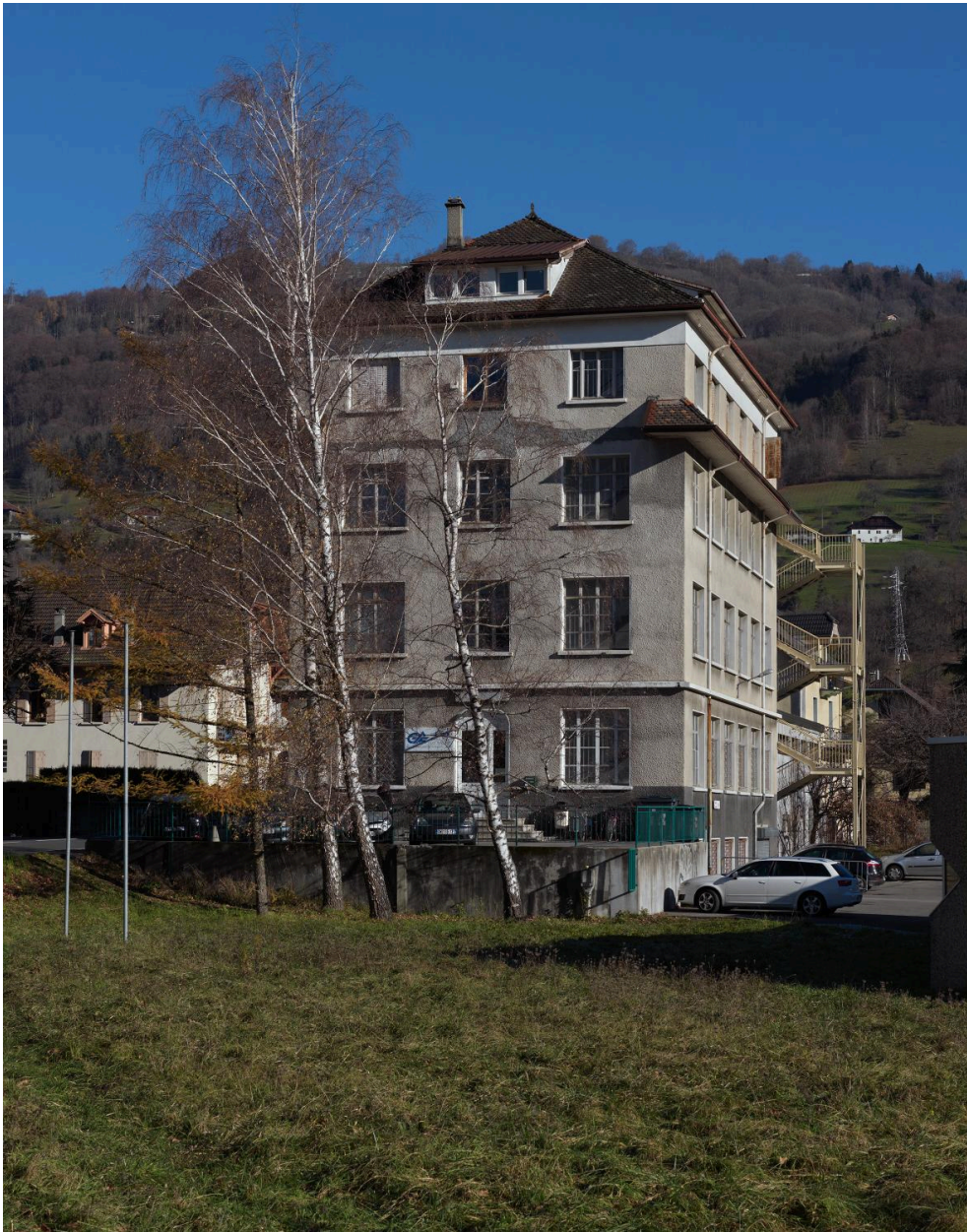
Vue d'ensemble sud de l'ancienne usine Ramel
