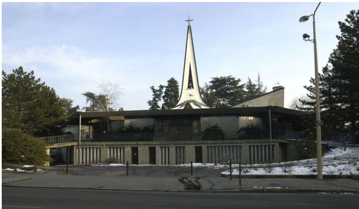
Vue générale rapprochée depuis l'ouest
