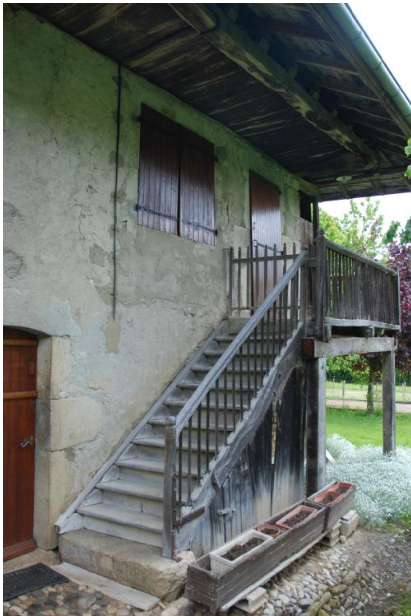
Détail de la partie habitation : escalier extérieur, calade.
