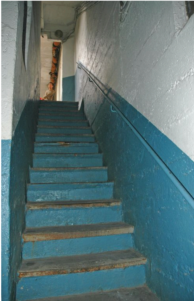
Escalier droit aménagé au sud-est du passage couvert
