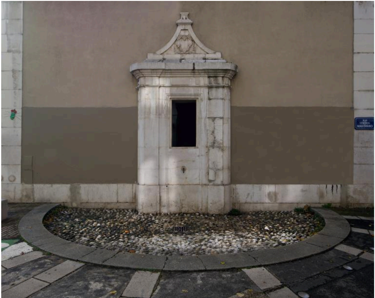
Fontaine des jésuites, état actuel
