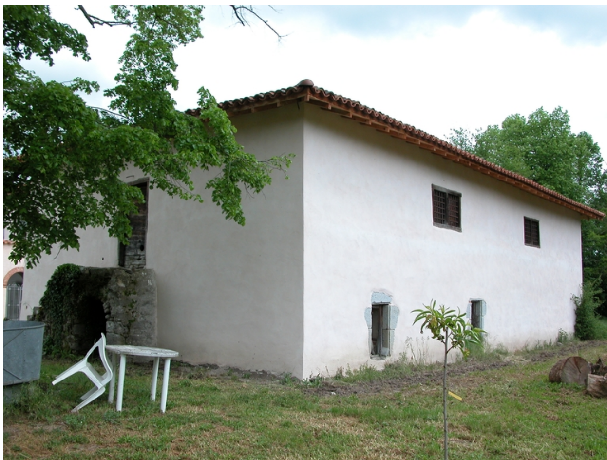
Vue de la grange-étable, depuis le sud-ouest.
