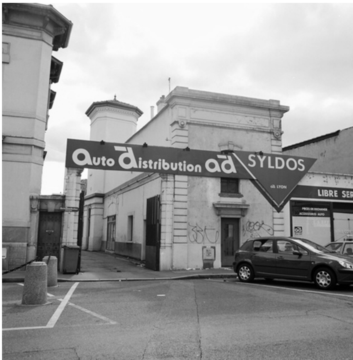
Vue générale nord
