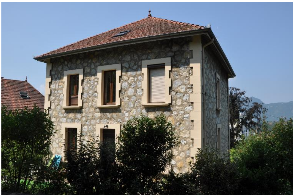
Vue sur l'élévation postérieure, orientée à l'est
