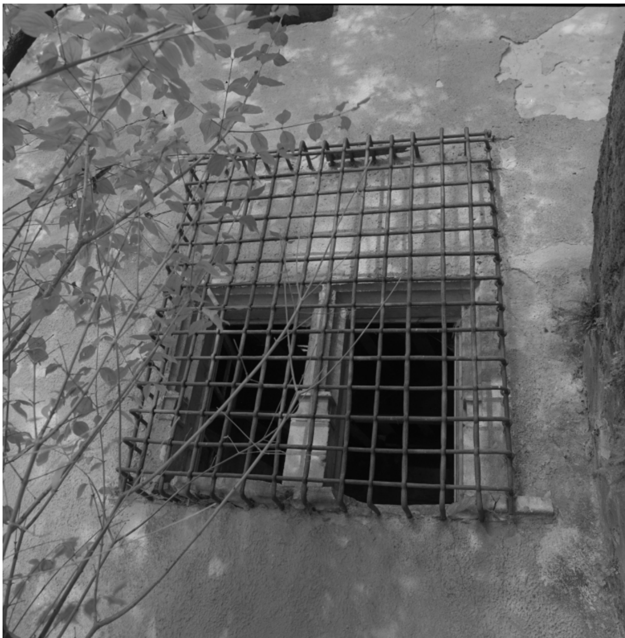
Salle du logis de l'aile gauche : fenêtre sur jardin avec grille.
