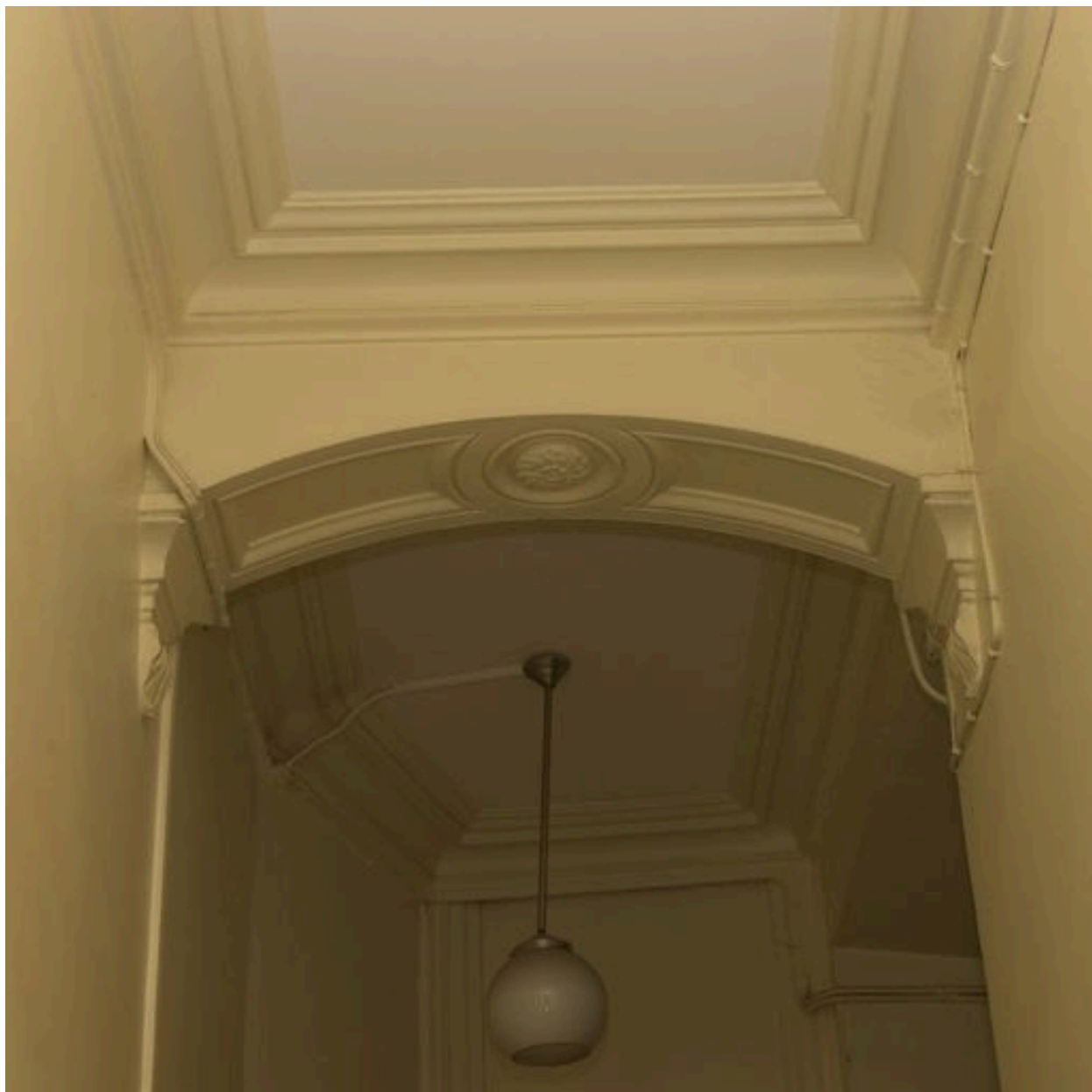
Détail de l'étrésillonement du vestibule
