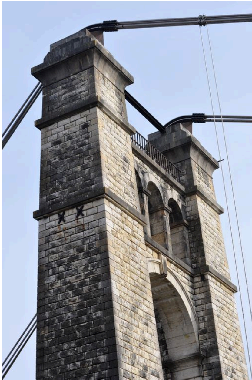
Pylône droit, face aval, vue partielle : sommet (depuis la rive droite)
