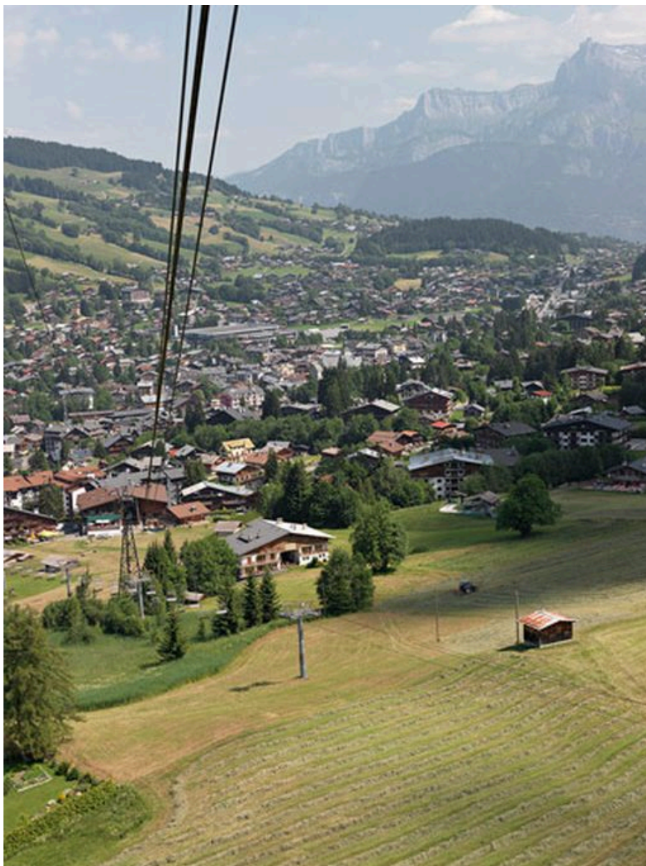
La ligne vers le dernier pylône depuis l'amont
