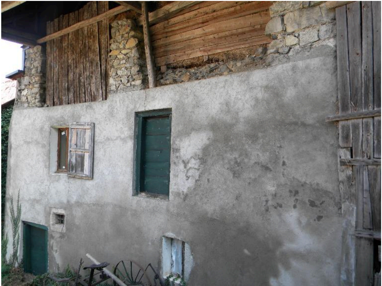
Détail de la façade arrière d'une ancienne ferme (2008 F7 865)
