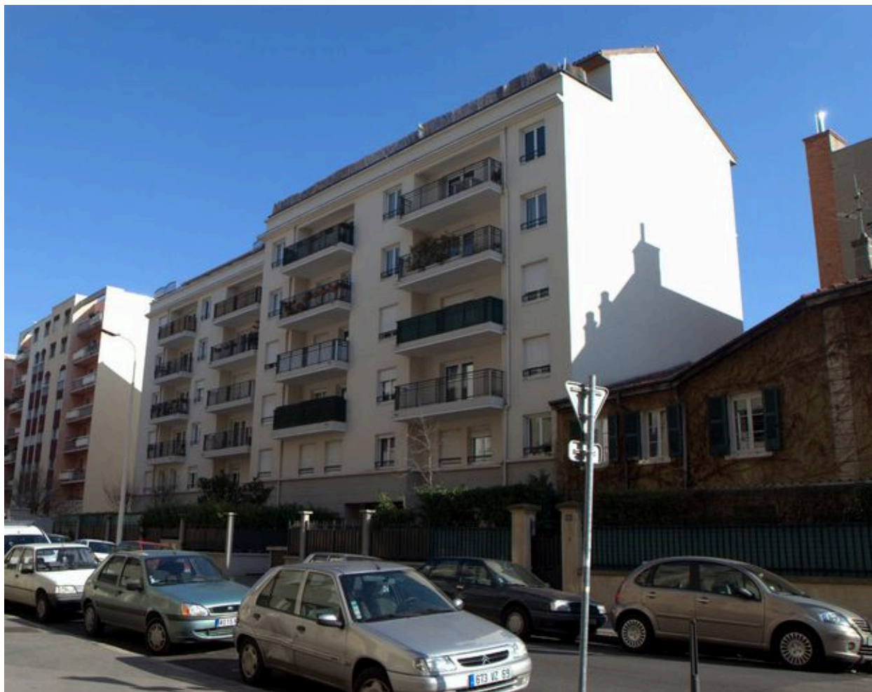
Vue générale depuis le sud-ouest
